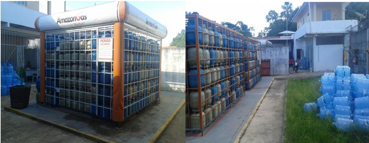
**Figura 03:** Área de Armazenamento e Estoque de GLP
